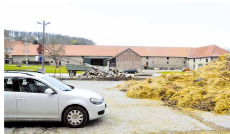
Auf einem Wirtschaftsgebäude des Klostergrundes Lamspringe ist eine Photovoltaik-Anlage geplant.
